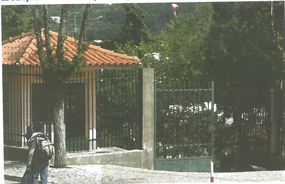
Escola EB 2/3 de Monchique ainda tem cobertura com amianto e será alvo de remodelação total
